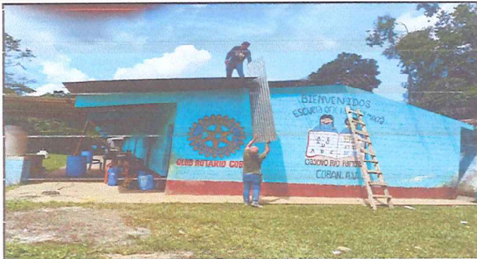
Foto1: Se observa el primer día de trabajo del retiro de cubierta de techo del edificio de 4 aulas, dirección y corredor. (06-11-2024).
